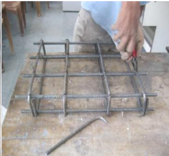
(d) Reinforcement cage formation
